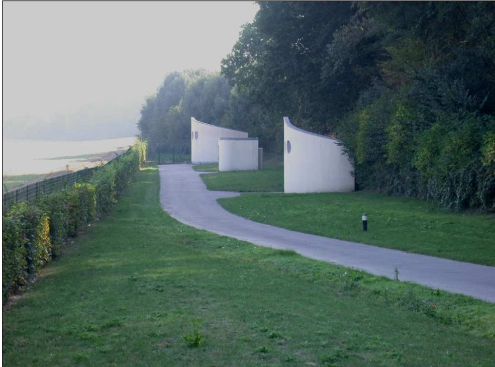
Station de pompage de Morchain
