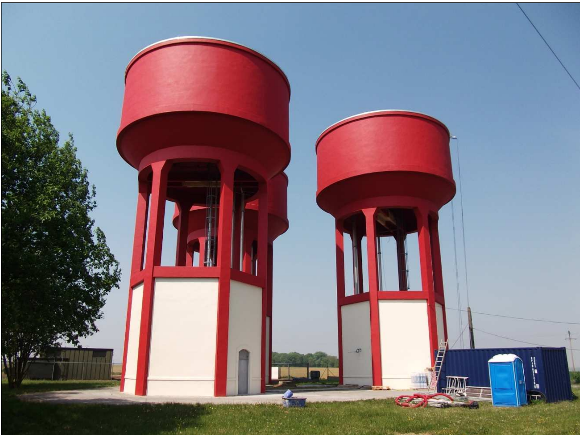
Réservoirs de Licourt
