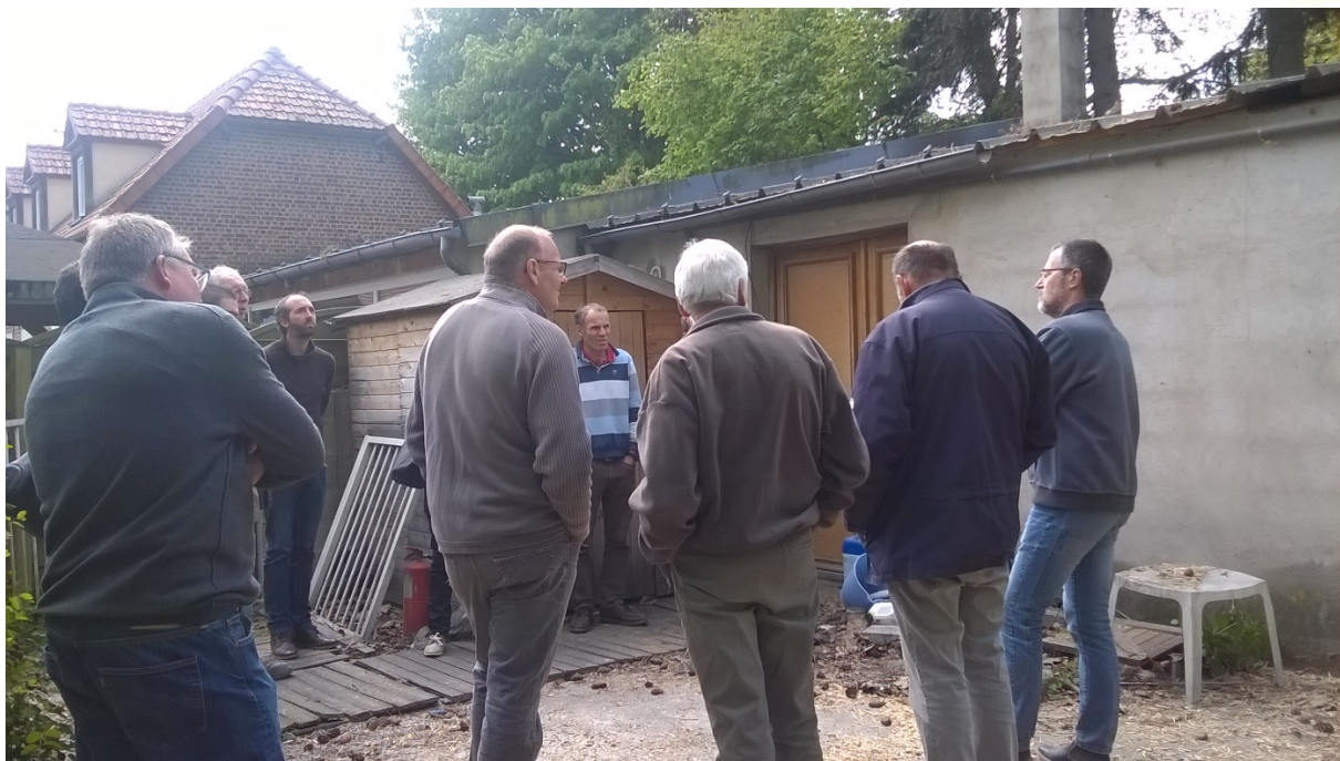
Photo 1: visite de la chaudière de Dominique de Thezy et de son silo de 30 m 3
